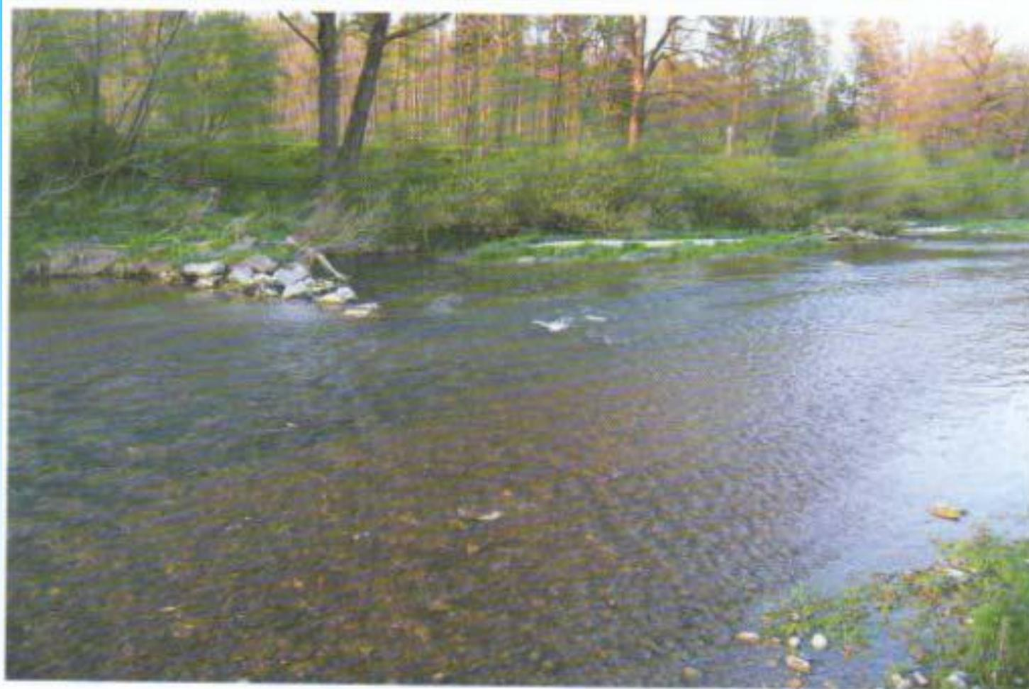
**Typische Situation an Buhnen: der Raum direkt hinter der Buhne wird durch die Überströmung der Buhne bei hohen Abflüssen freigehalten. Die Ablagerungen beginnen erst weiter unterstrom. .**
